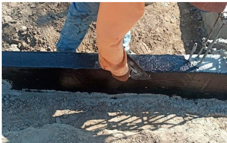
Figura 23 Viga de cimentación con impermeabilizante asfáltico
