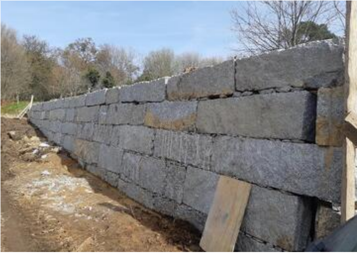
Figura 53. Muro piedra formando bloque
