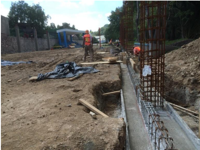
Figura 17 Zapata corrida con refuerzo
