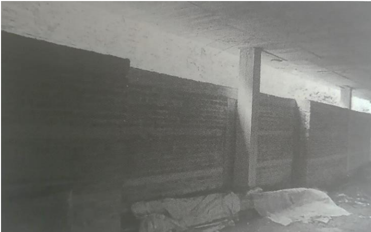
Figura 61: Muro mampostería confinada
