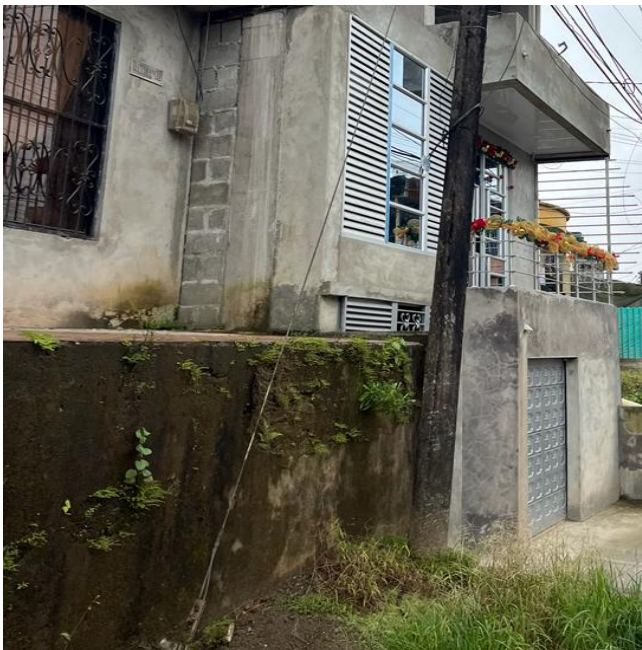
Figura 33 Vivienda de un piso
