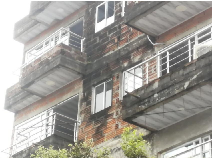
Figura 34 Edificio de oficinas
