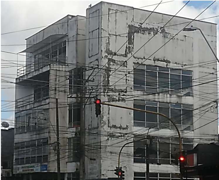
Figura 32 Edificación de oficinas calle 31 esquina
