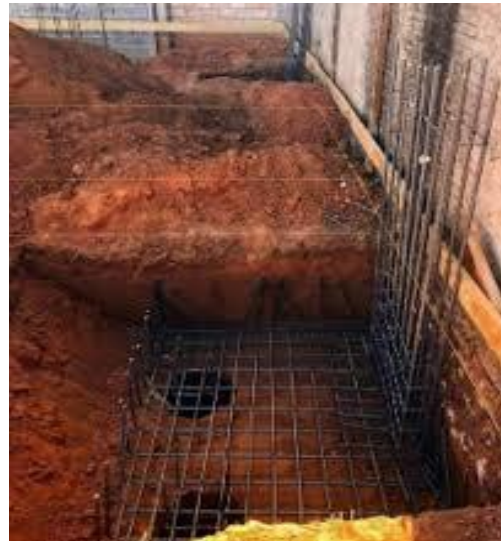
Figura 18 Zapata excéntrica con refuerzo
