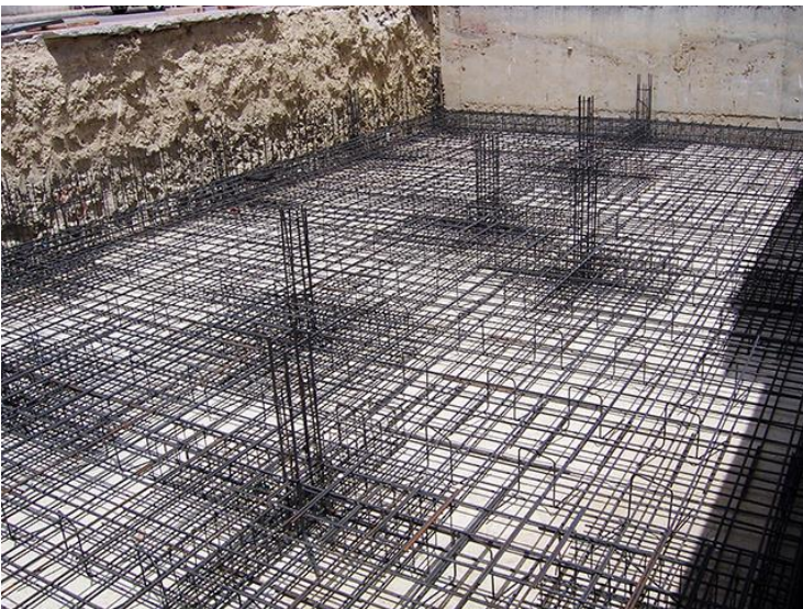
Figura 20 Losa de cimentación con refuerzo
