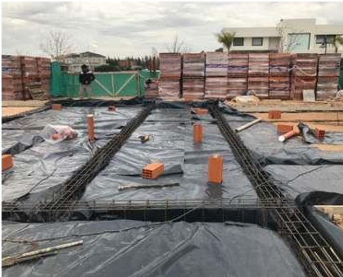
Figura 22 Viga de cimentación con impermeabilizante plástico
