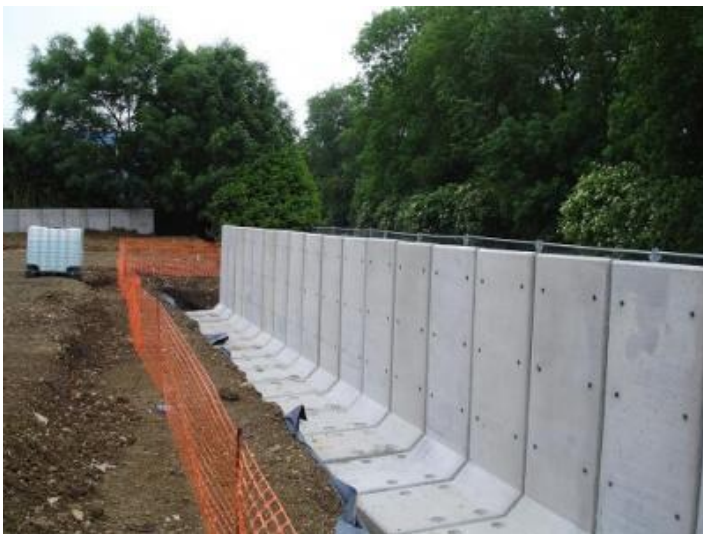
Figura 56: Muro en voladizo prefabricado
