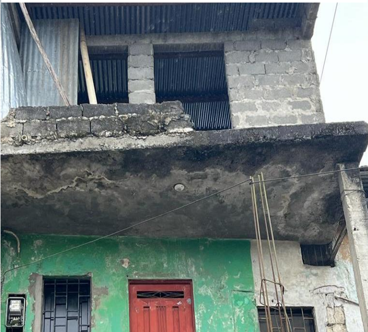
Figura 35 Vivienda de dos pisos
