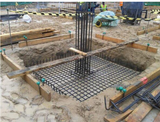
Figura 16 Zapata aislada con refuerzo
