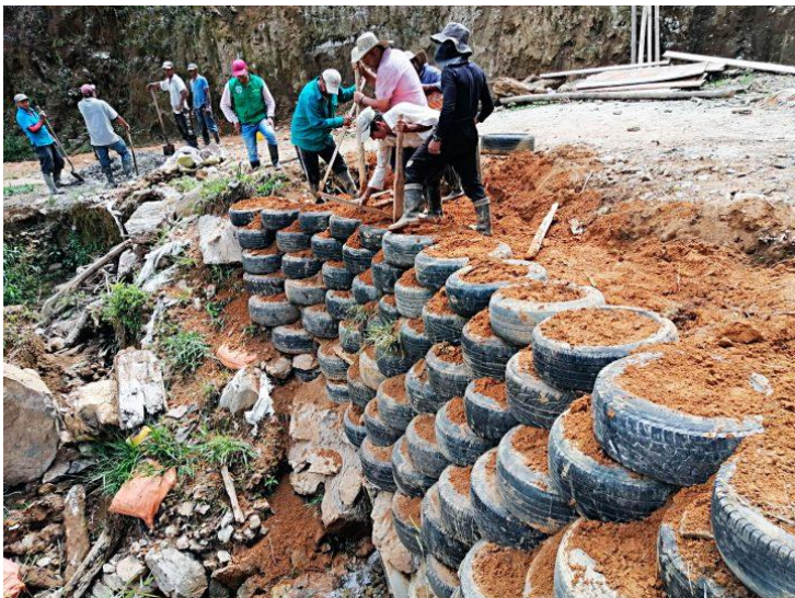
Figura 55. Muro en geotextil
