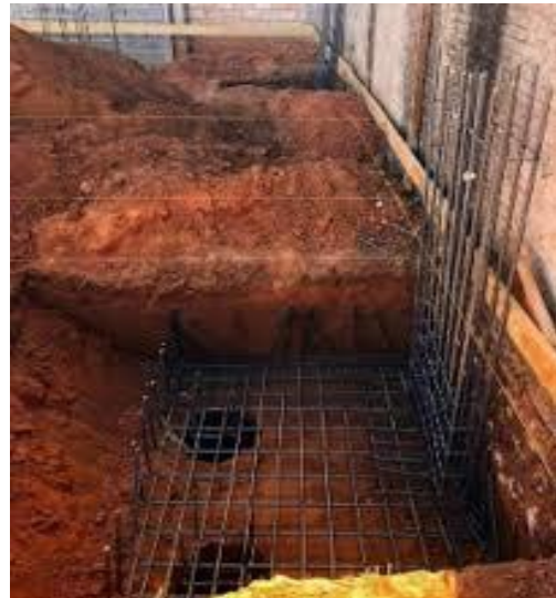
Figura 18 Zapata excéntrica con refuerzo
