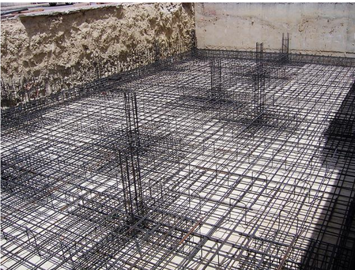
Figura 20 Losa de cimentación con refuerzo
