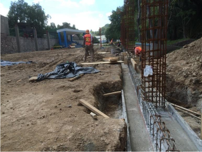
Figura 17 Zapata corrida con refuerzo
