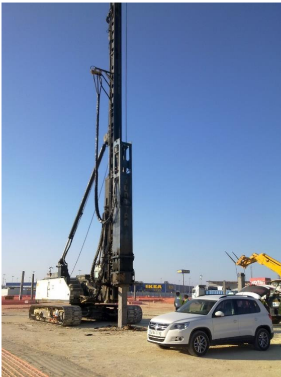
Figura 24 Maquinaria para hincar pilotes prefabricados
