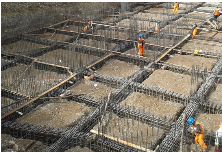
Figura 21 Losa de cimentación con refuerzo
