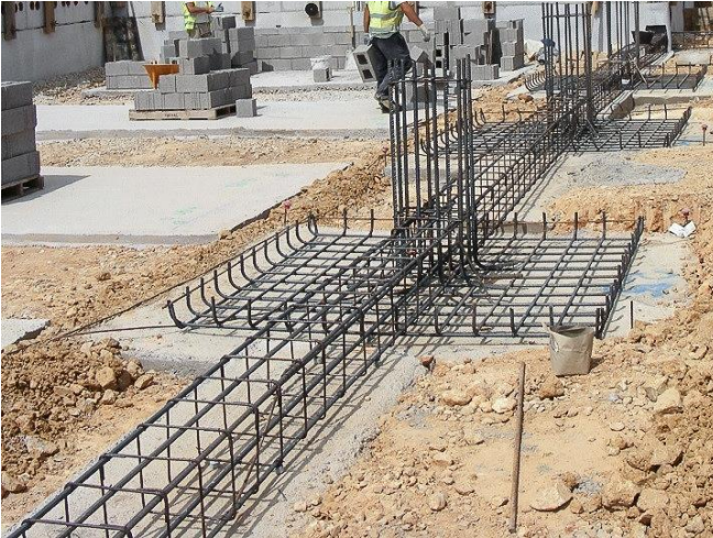
Figura 19 Zapata unidad con viga con refuerzo
