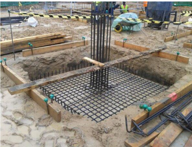
Figura 16 Zapata aislada con refuerzo
