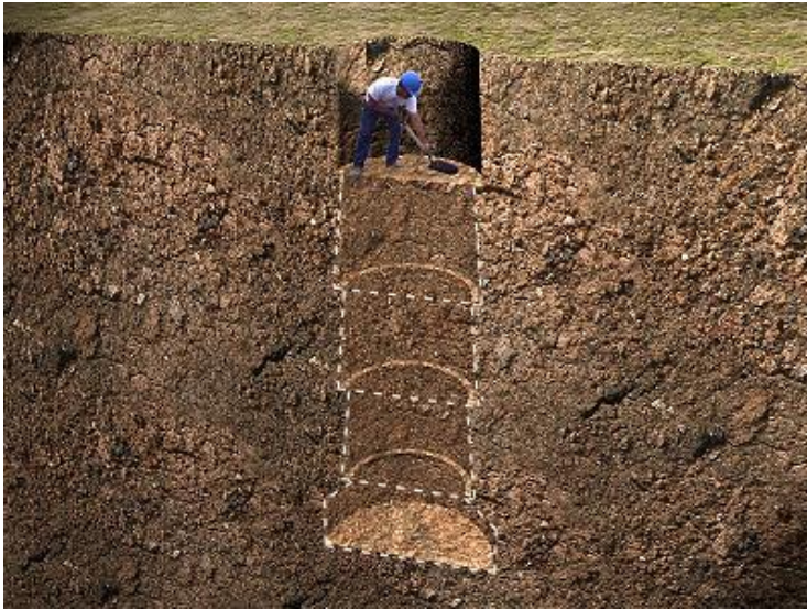
Figura 25 Excavación pozo de cimentación
