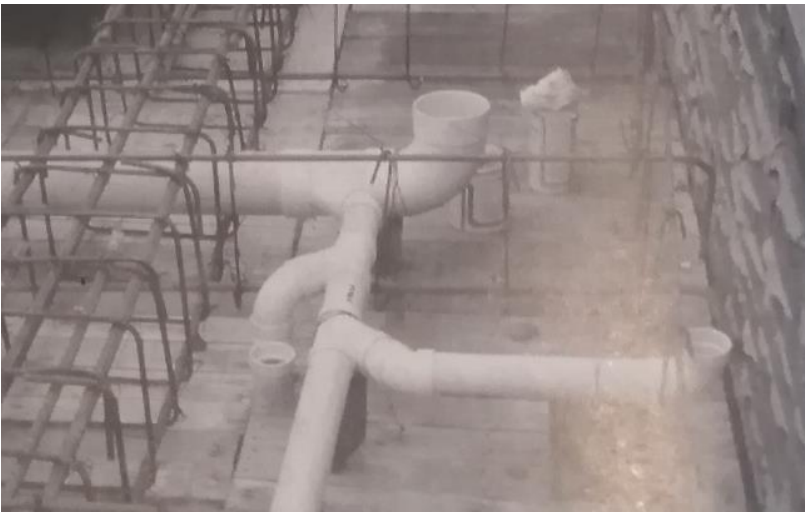
Figura 46: Tubería sanitaria conformando su pendiente
