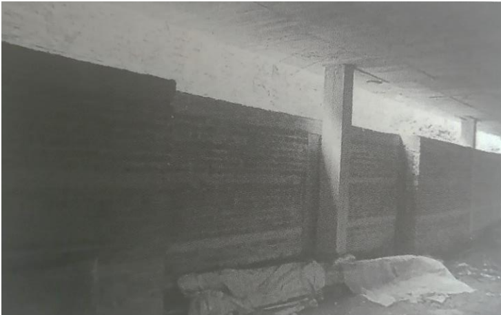
Figura 61: Muro mampostería confinada
