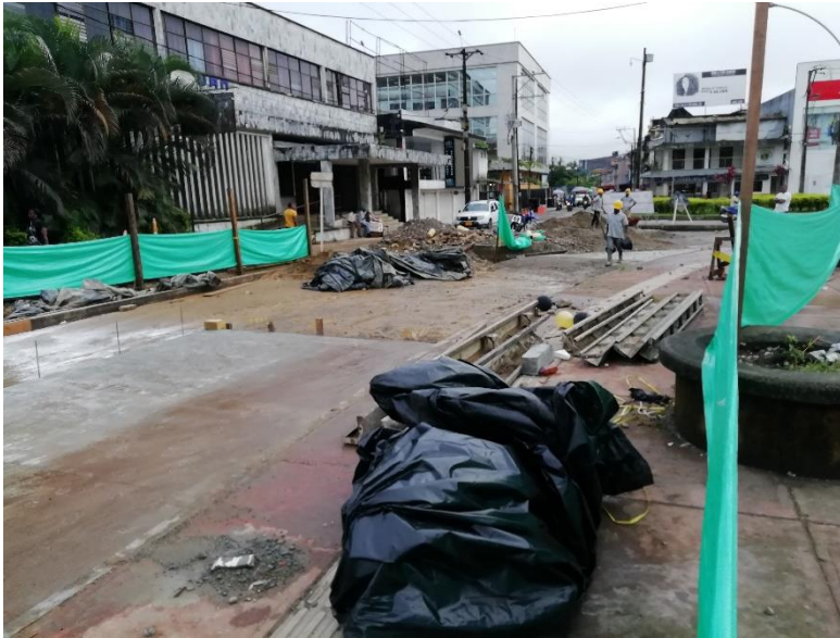
Figura 4. Construcción de pavimento Cra 1
