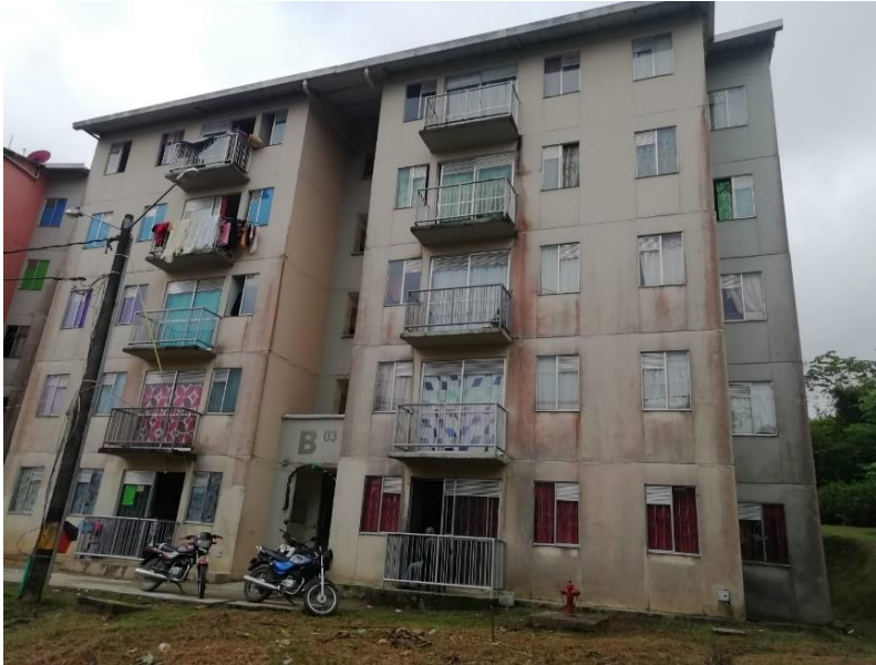
Figura 3. Edificio materializado con formaleta (Ciudadela MIA)
