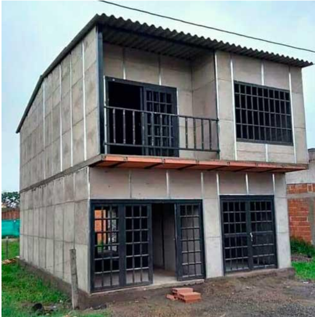
Figura 5. Construcción de prefabricada
