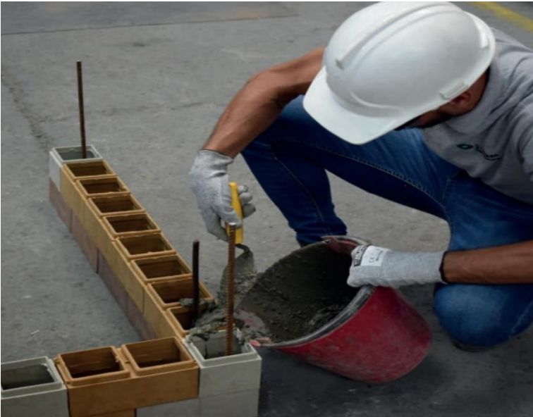
Figura 62: Proceso constructivo mampostería estructural
