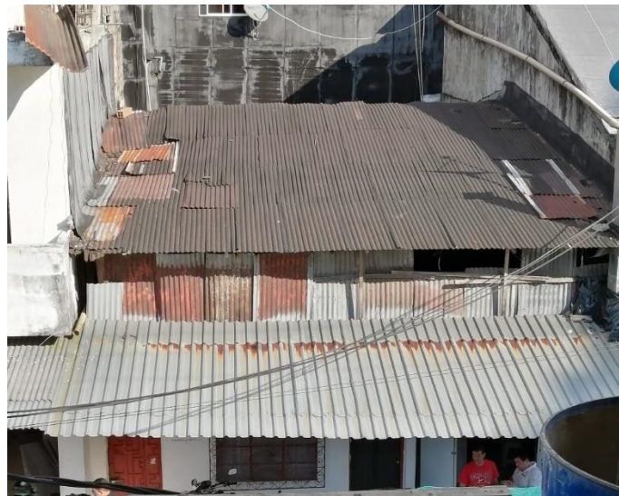
Cubierta en lamina de zinc deteriorada
