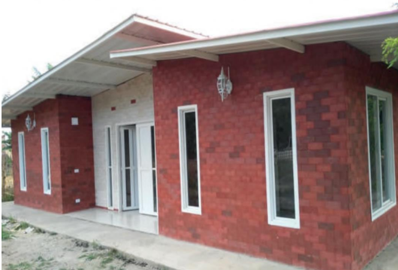
Figura 63: edificación de un piso con acabado original del material
